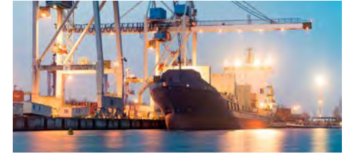
Extension du port de Tuléar
