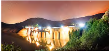
Aménagement de la centrale hydroélectrique Antetetzambato 140MW
