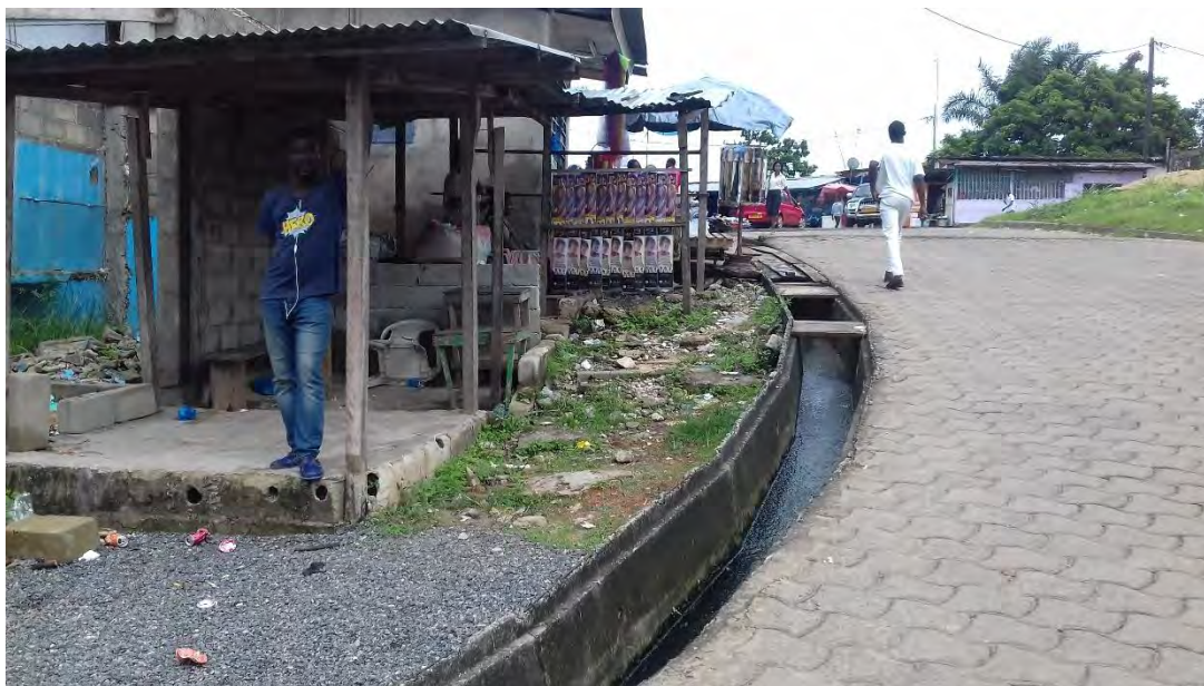
Photo 6 : Canalisation servant d'évacuation des eaux de ruissellement et des eaux usées
