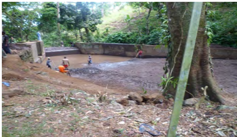
Figure 3.6 Envasement des captages
